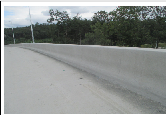
방호벽 시공 상태 점검
