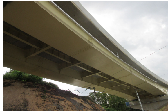
슬래브 하부 전경
