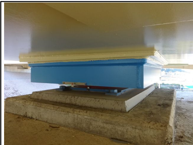
교량받침 P1-SH1 전경
