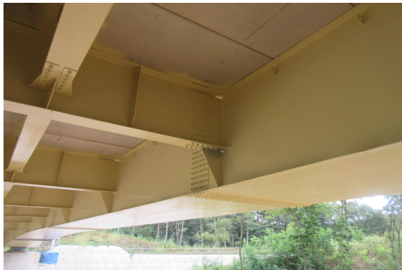
BOX 외부 시공 상태 점검
