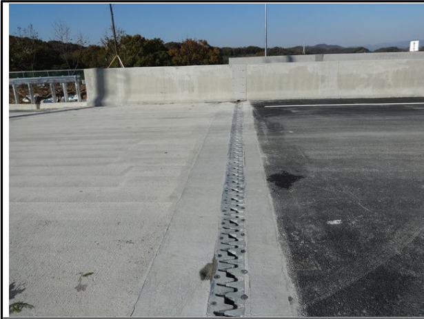
신축이음 A1 전경
