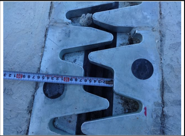
신축이음 A1 유간 측정
