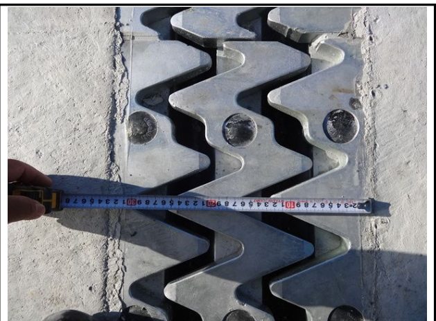
신축이음 P4 유간 측정
