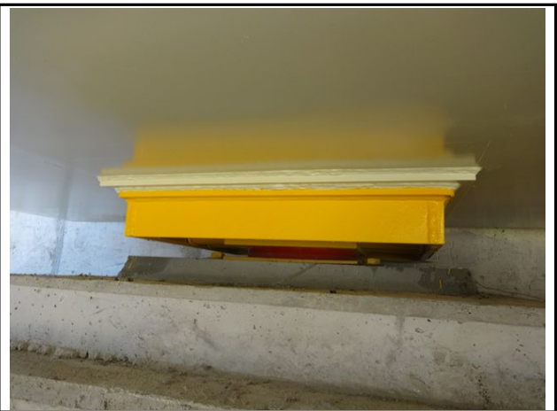
교량받침 A2-SH2 전경
