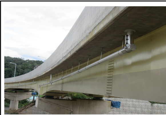
배수관 시공 상태 점검
