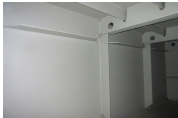
BOX 내부 시공 상태 점검
