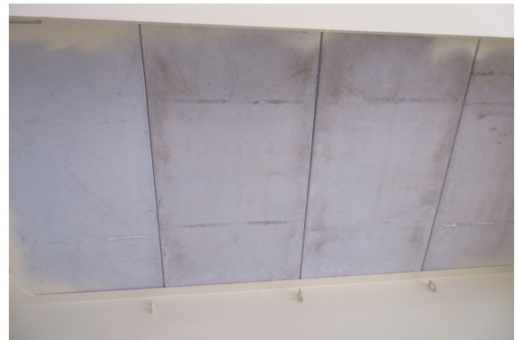
바닥판 하면(LB-DECK) 시공 상태 점검
