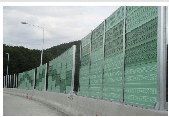
방음판 시공 상태 점검
