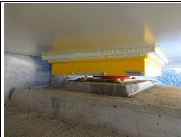
교량받침 A1-SH1 전경
