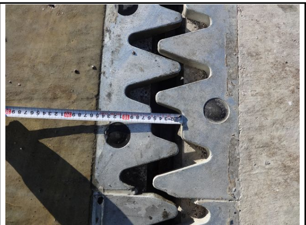
신축이음 A2 유간 측정
