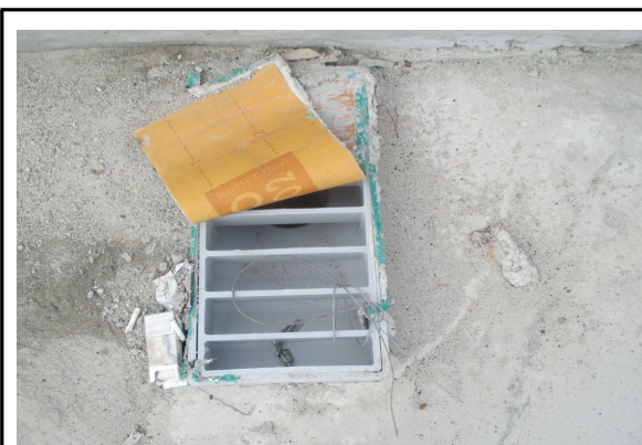
배수구 시공 상태 전경(완료전)
